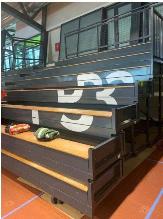
Slika 3. Teleskopsko gledalište u atletskoj dvorani Kantrida
