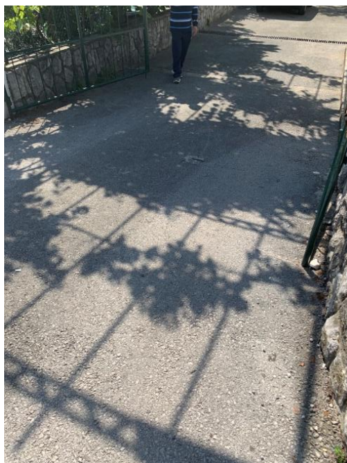
Slika 46. Pristup s prometnice boćarskom centru Podvežica
