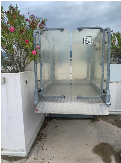
Slika 15. Vertikalno podizna platforma prema vanjskom bazenu Kantrida
