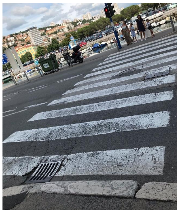
Slika: Ribarska ulica pješački prijelaz 2. (osobna arhiva)
