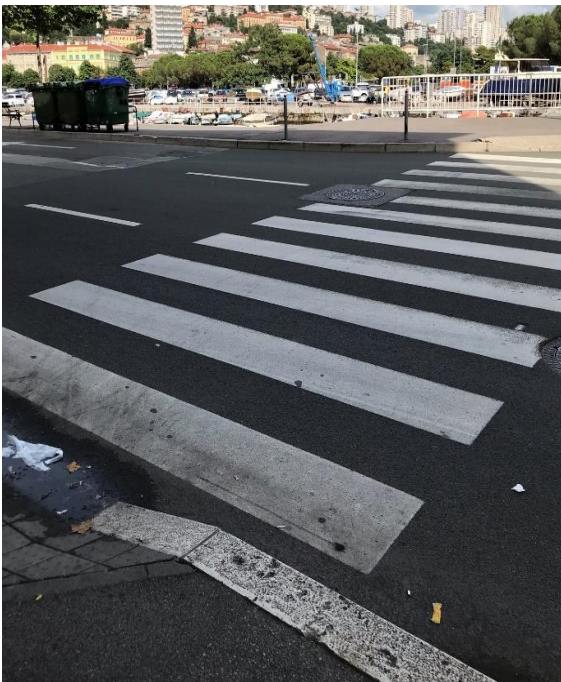
Slika: Ribarska ulica pješački prijelaz 1. (osobna arhiva)
