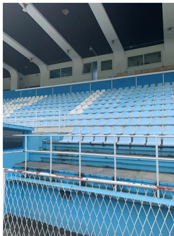
Slika 10. Onemogućen pristup gledalištu osobama s invaliditetom na stadionu Kantrida
