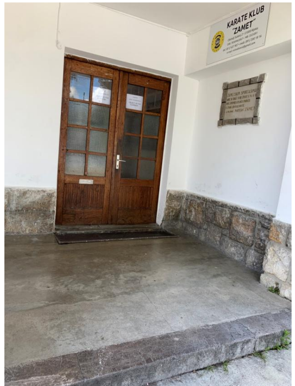
Slika 30. Neprilagođen pristup karate klubu za osobe s invaliditetom u SRC-u Zamet
