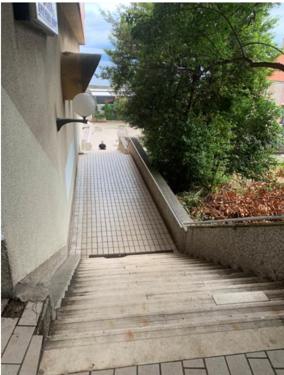
Slika 20. Neprilagođen pristup SRC-u 3. maj s prometnice za osobe s invaliditetom
