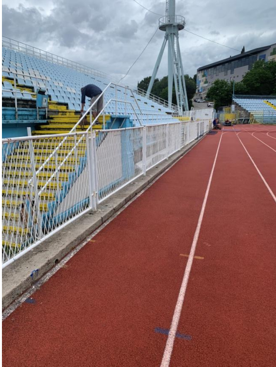
Slika 9. Teren na stadionu Kantrida u ravni s ulazom
