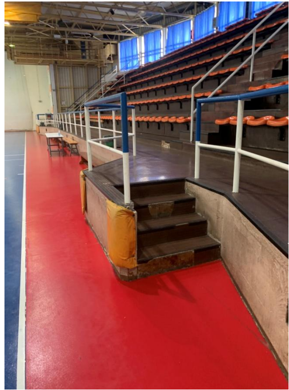
Slika 23. Neprilagođen pristup gledalištu za osobe s invaliditetom u SRC-u 3. maj
