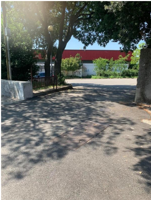
Slika 62. Pristup dvorani Dinko Lukarić s prometnice
