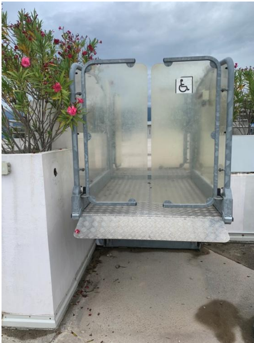
Slika 15. Vertikalno podizna platforma prema vanjskom bazenu Kantrida
