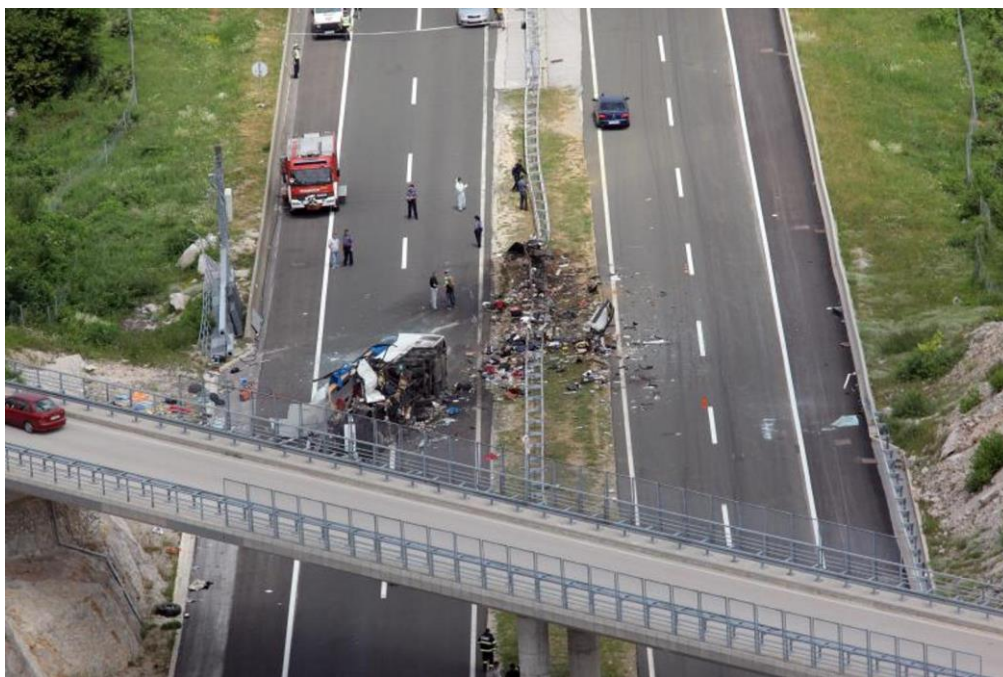
Slika 6. Pogled na mjesto nesreće i probijenu zaštitnu ogradu iz zraka
