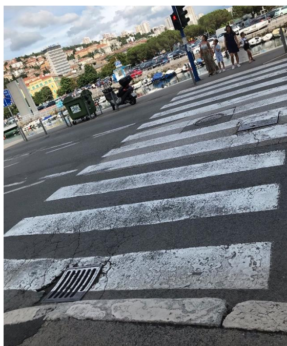
Slika: Ribarska ulica pješački prijelaz 2. (osobna arhiva)
